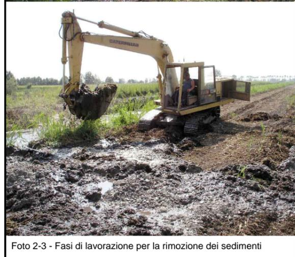
Foto 2-3 - Fasi di lavorazione per la rimozione dei sedimenti
