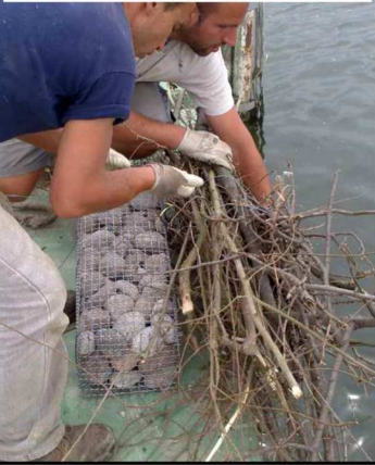
Fig.7 - Fase di legatura delle fascine
