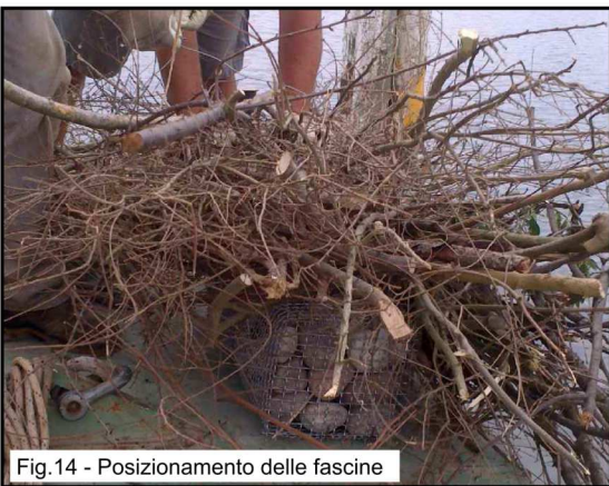
Fig.14 - Posizionamento delle fascine
