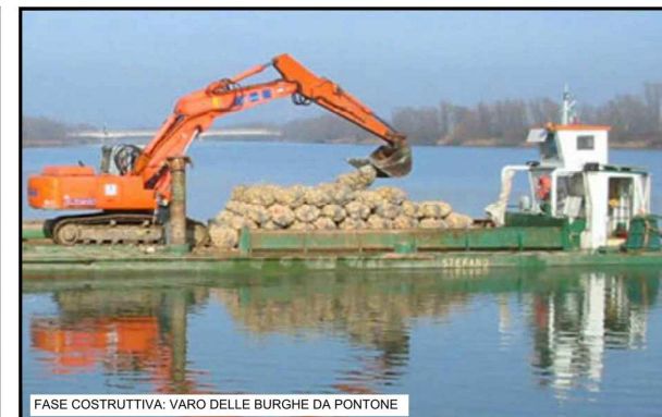
FASE COSTRUTTIVA: VARO DELLE BURGHE DA PONTONE
